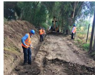
**Hacia la Plaza de Champa:** desde esta zona se continúa con la instalación de la red de conducción en PVC en diámetro de 200mm en dirección a la plaza de Champa, contemplando la rotura y reposición de más de 1.000 mts. de veredas, donde se conectará al sistema de producción ubicado en esa localidad. Este trabajo se planificó en conjunto con los vecinos del sector por tratarse de pavimentos ejecutados por ellos mismos, lo que generará una mejora en la calidad de la pavimentación.
